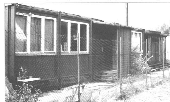
Kontenery. Morskie Laboratorium Terenowe w latach 1984-1991 r.
