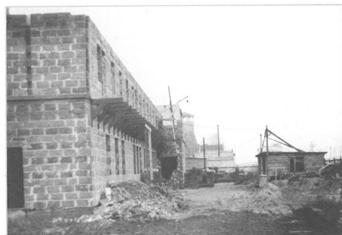
Budowa nowej Stacji Morskiej (1987 r.)
